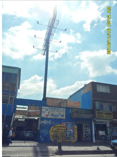
Fotografía No. 4 Fachada del inmueble ubicado en la AVENIDA CARRERA 86 No 75A-18
